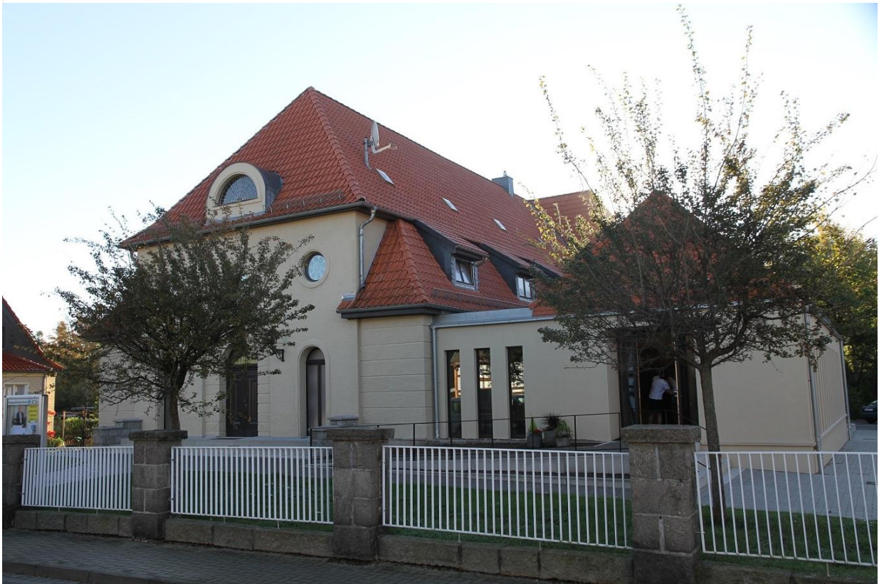
Das wiedereröffnete Kirchengebäude
