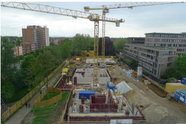
Blick über den Bauplatz für das neue Kirchenzentrum
