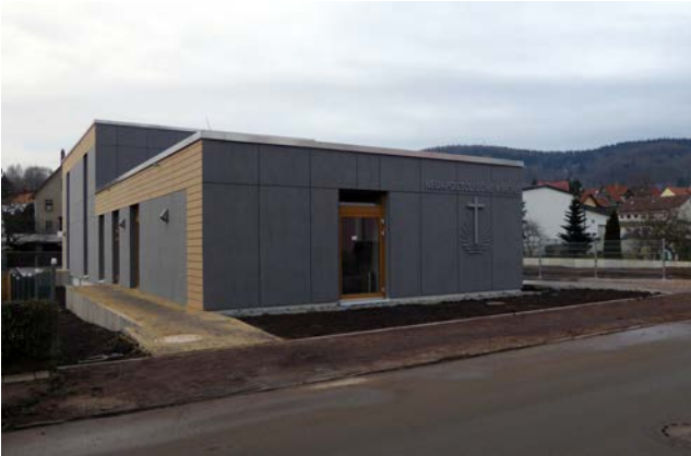
Außenansicht des Neubaus kurz vor der Fertigstellung
