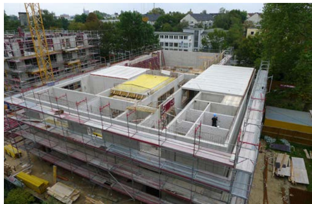
Der Rohbau im September 2014
