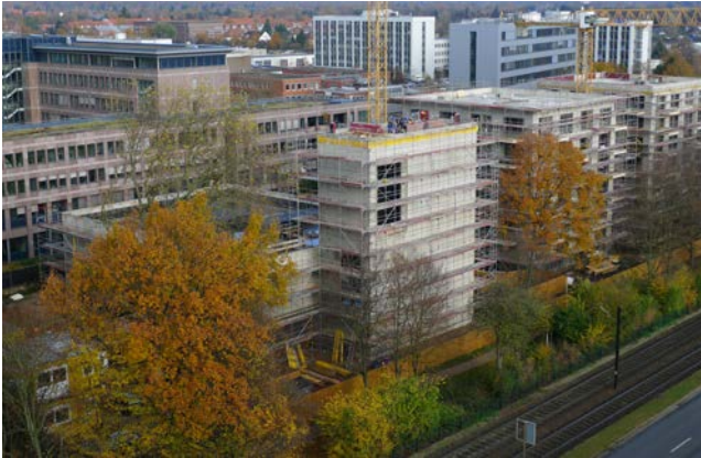
Der Neubau-Komplex entlang der Garkenburgstraße im November 2014
