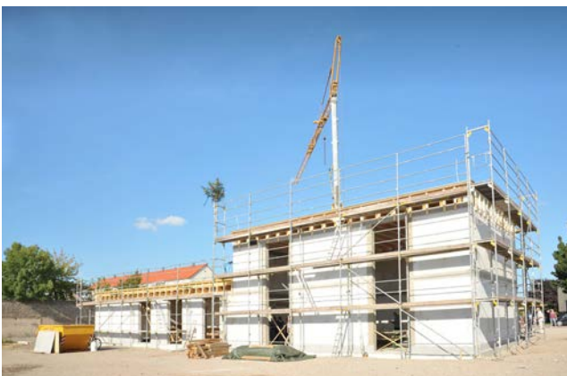
Richtfest im August 2014
