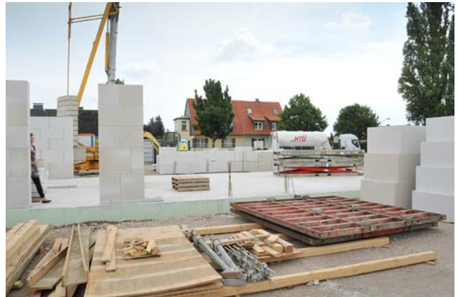
Der Rohbau wächst
