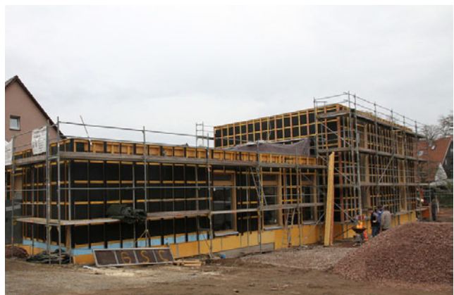
Der Rohbau im Oktober 2013
