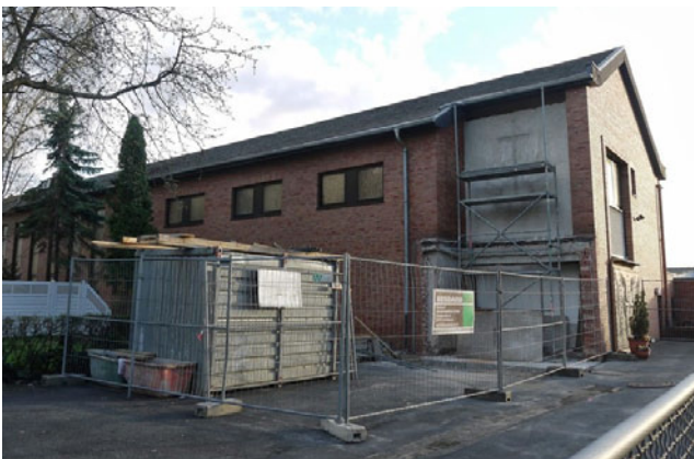
Erste Bauarbeiten am Eingangsbereich der Kirche Göttingen
