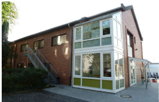
Der Eingangsbereich nach dem Umbau: rechts der neue Gebäudeeingang, im verglasten Anbau oben die erweiterte Sakristei und unten der neue Raum für die Vorsonntagsschule
