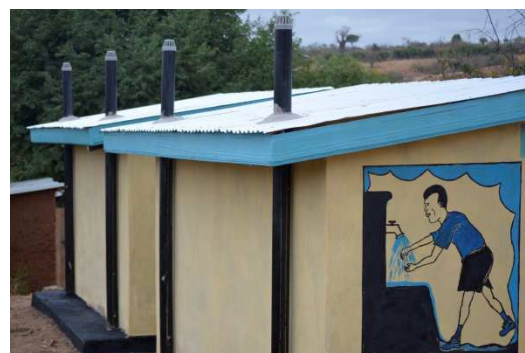
Toilettenhäuser in der Schule in Ikomenie
