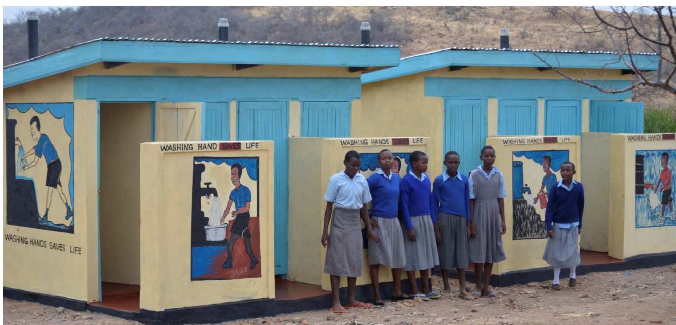
Toilettenhäuser in der Schule in Ikomenie, Zentralkenia
