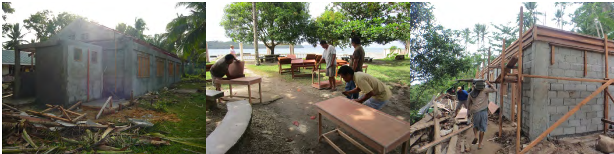
Wiederaufbau Libas Elementary School (Samar)
